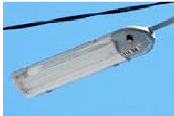
A T5 luminaire
